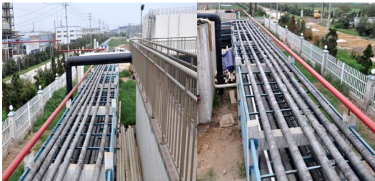
图 2.5-3 园区污水处理厂“一企一管”管廊图
