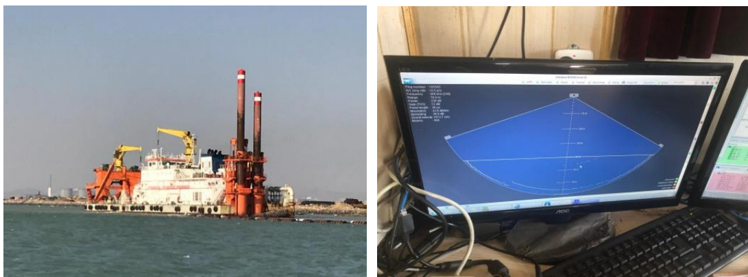
图 5.1-2 施工船舶与定位系统
