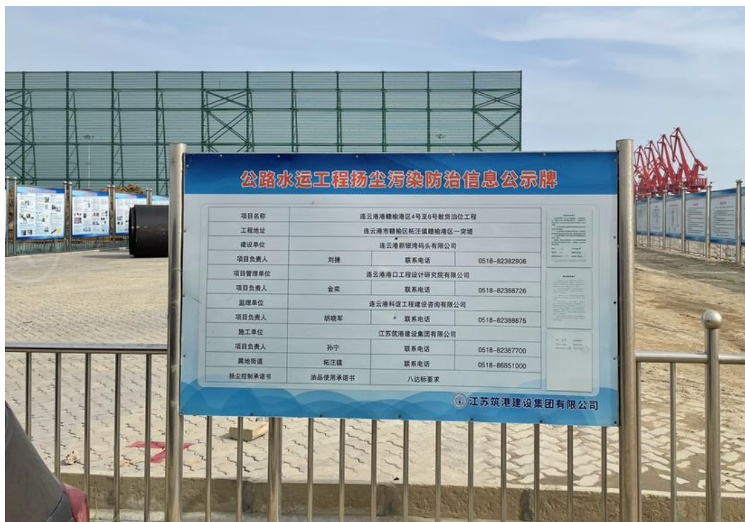
图 5.1-13 施工现场扬尘污染防治公示牌
