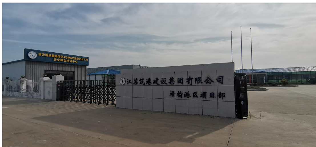
图 5.1-6 项目施工营地
