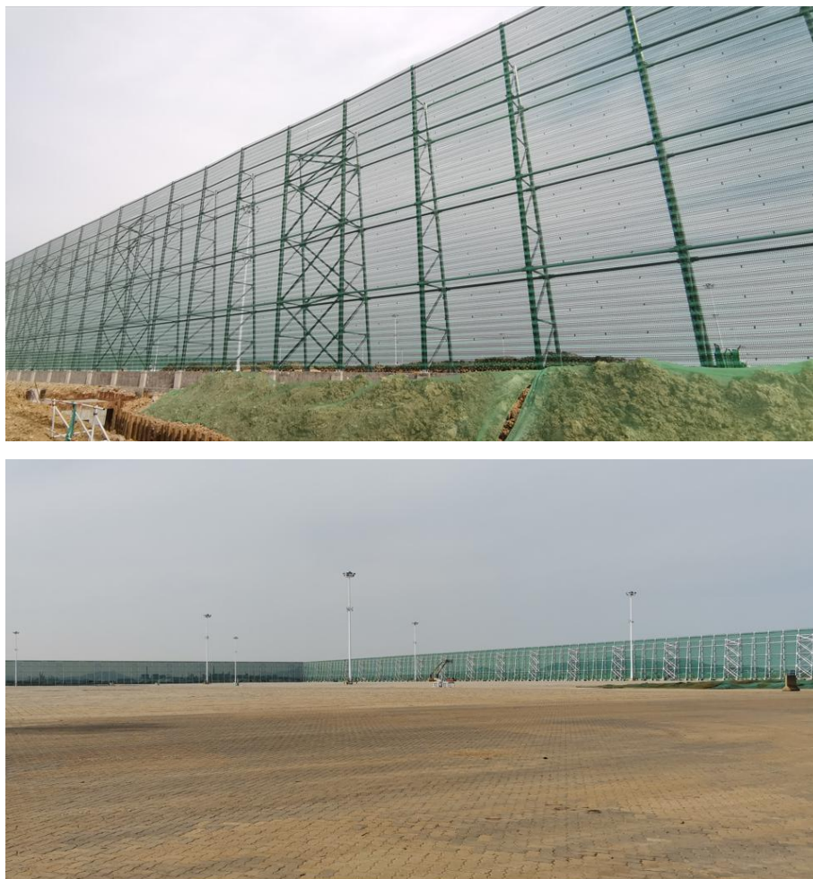
图 5.2-16 堆场设置的防风防尘网照片
