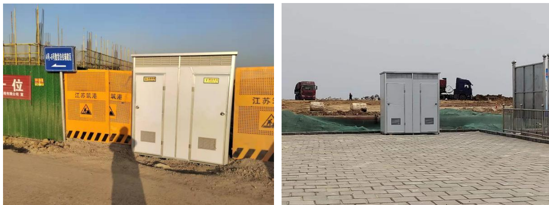
图 5.1-5 施工现场环保卫生间
