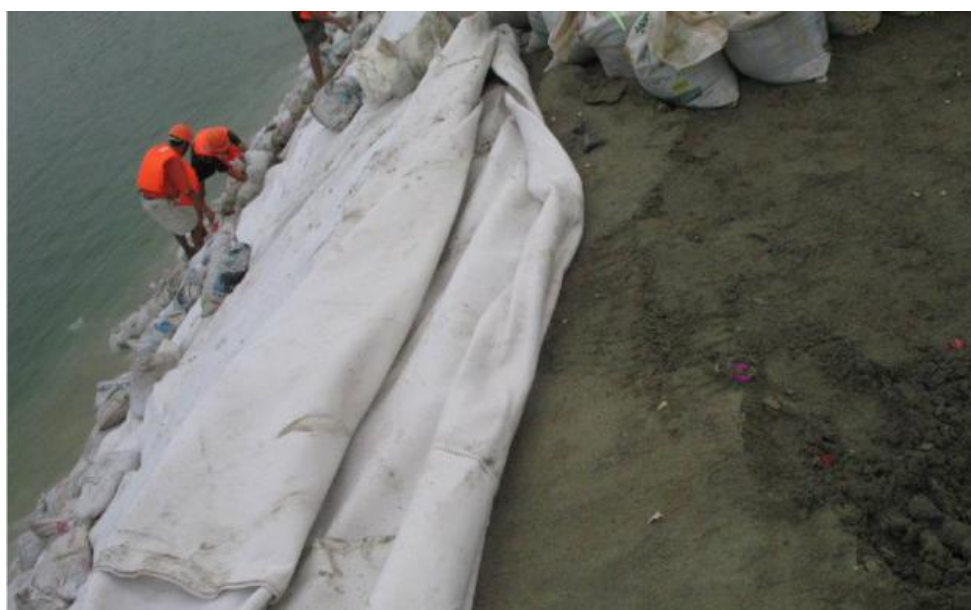
图 5.1-3 吹填围堰倒滤层
