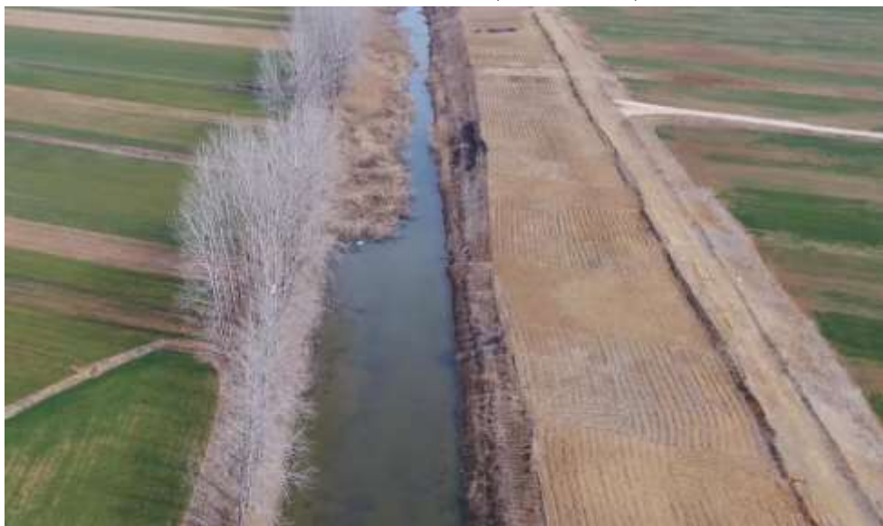
图 3-3 现状堤顶(桩号 56+000)
