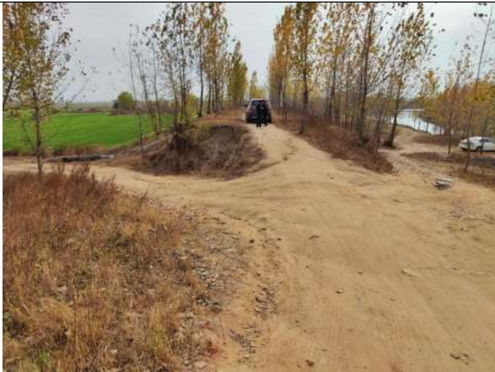
图 3-2 现状局部堤顶(桩号 20+700)
