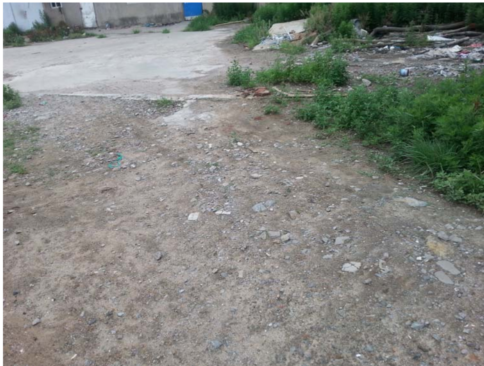
图 2-2 110kV 连岛变电站站址现场
